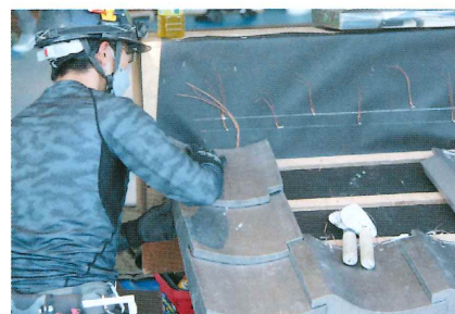
瓦葺（施工実演）
